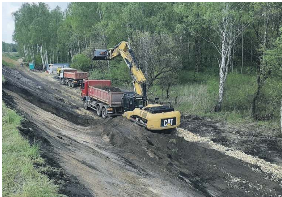
Prace przy wzmacnianiu nasypu między Trzebiną a Chrzanowem są wykonywane na odcinku 150 metrów
