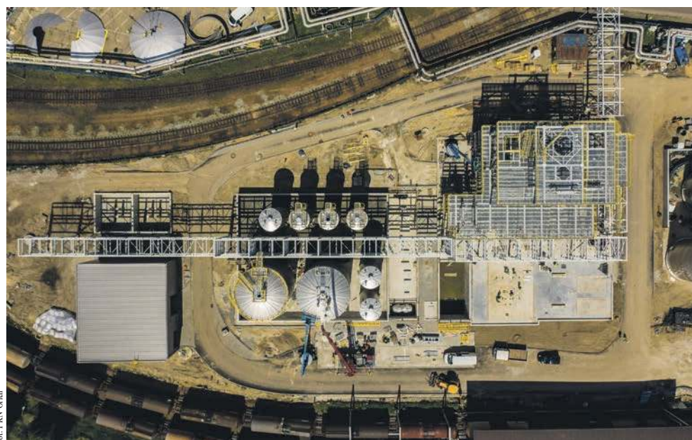
Inwestycja powinna być gotowa na koniec 2021 roku
