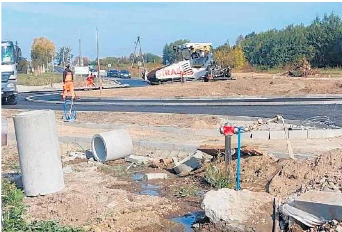
Na Gołębiowie trwa budowa ostatniego odcinka trasy N-S co wiąże się z utrudnieniami w tej części miasta.
