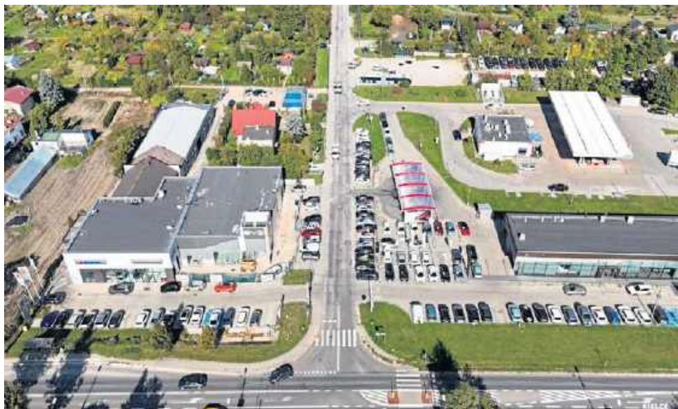
W piątek, 9 października zacznie się remont ulicy Gustawa Morcinka w Kielcach
