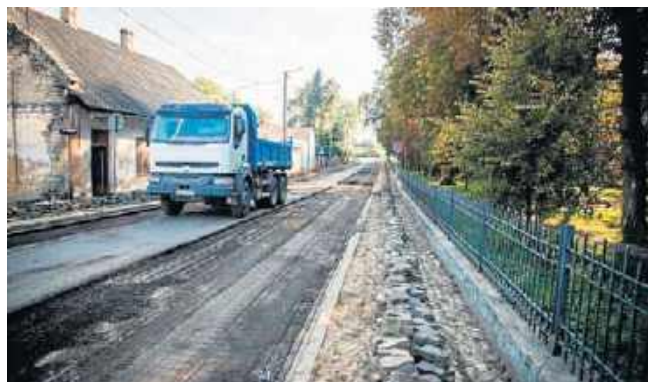
Na teren inwestycji przy Zalewie nad Czarną w Staszowie wjechał ciężki sprzęt.
