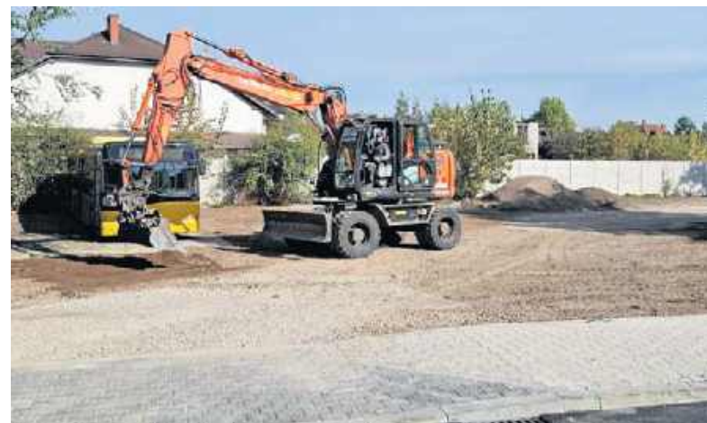
Przy ulicy Idalińskiej w Radomiu trwają ostatnie prace porządkowe. Prace mają się zakończyć do 19 października.
