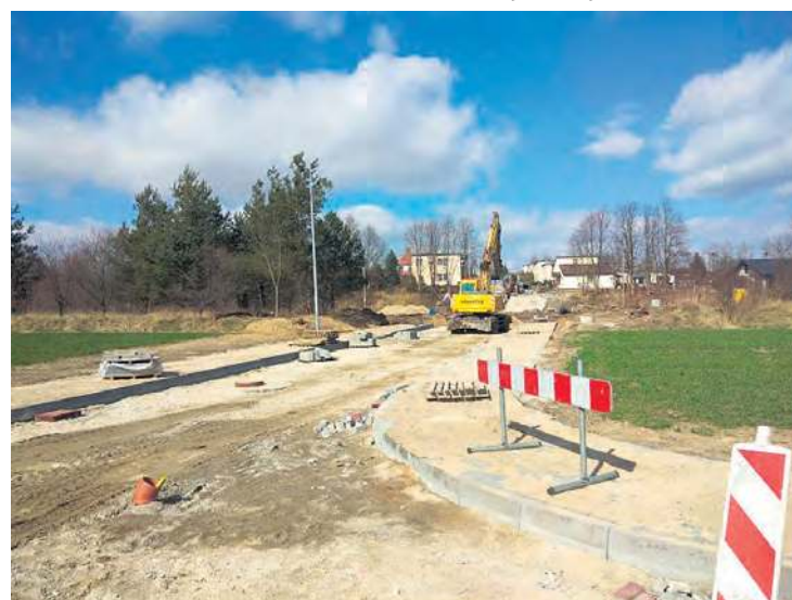
Prace na ulicy Szkolnej w Gostycynie.
