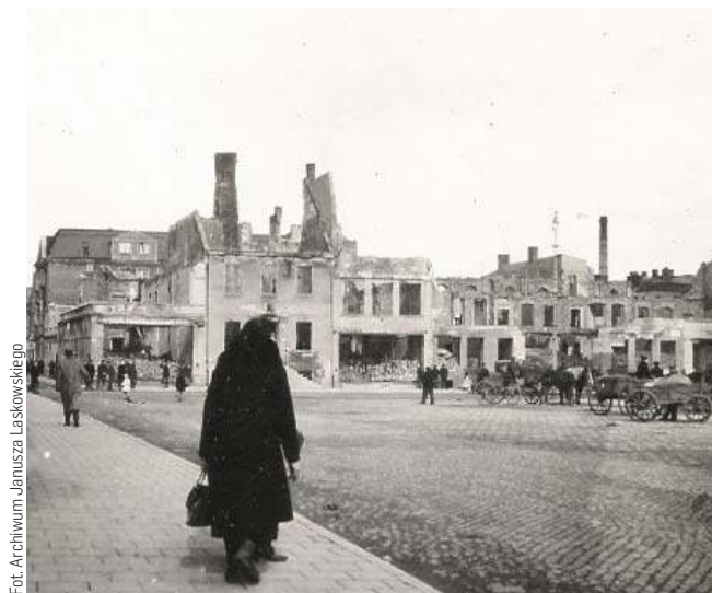
Niektóre ze zniszczonych domów na północnej stronie rynku odbudowano dopiero w latach 60 — tych miniego wieku
