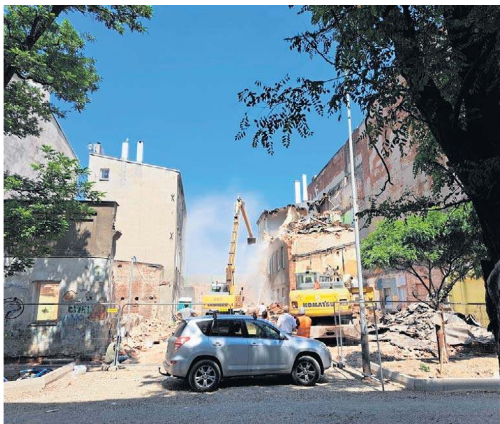
Wyburzanie kamienicy przy ul. Mielczarskiego. Budynek nie wytrzymałby drgań
