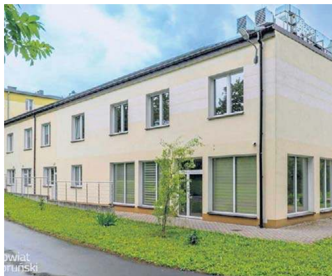
Po modernizacji cały kompleks ZOL będzie oferował standard opieki dostępny obecnie w nowej części budynku
