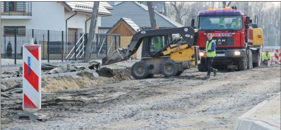
Magistrat zapewnia, że prace na ul. Rataja prowadzone są zgodnie z dokumentacją projektową, która została przygotowana już kilka lat temu, podczas pierwszego remontu niewielkiego odcinka drogi przy szkole
