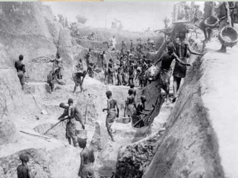
Na budowie linii kolejowej w Kongu Belgijskim, 1923–24 r.
