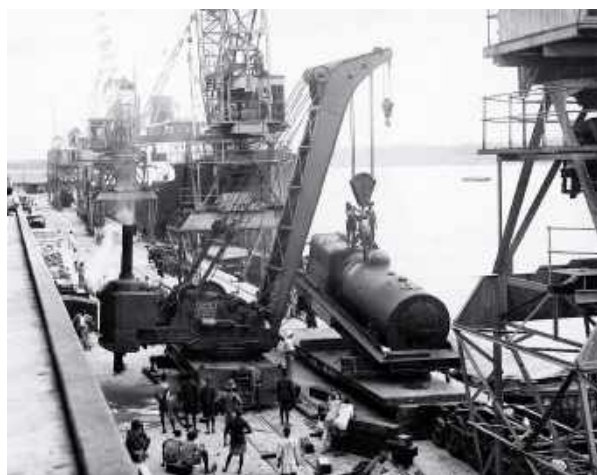
Port w Mombasie, rozładunek części pociągu dla zbudowanej linii kolejowej, Brytyjska Afryka Wschodnia (Kenia), lata 20. XX w.
