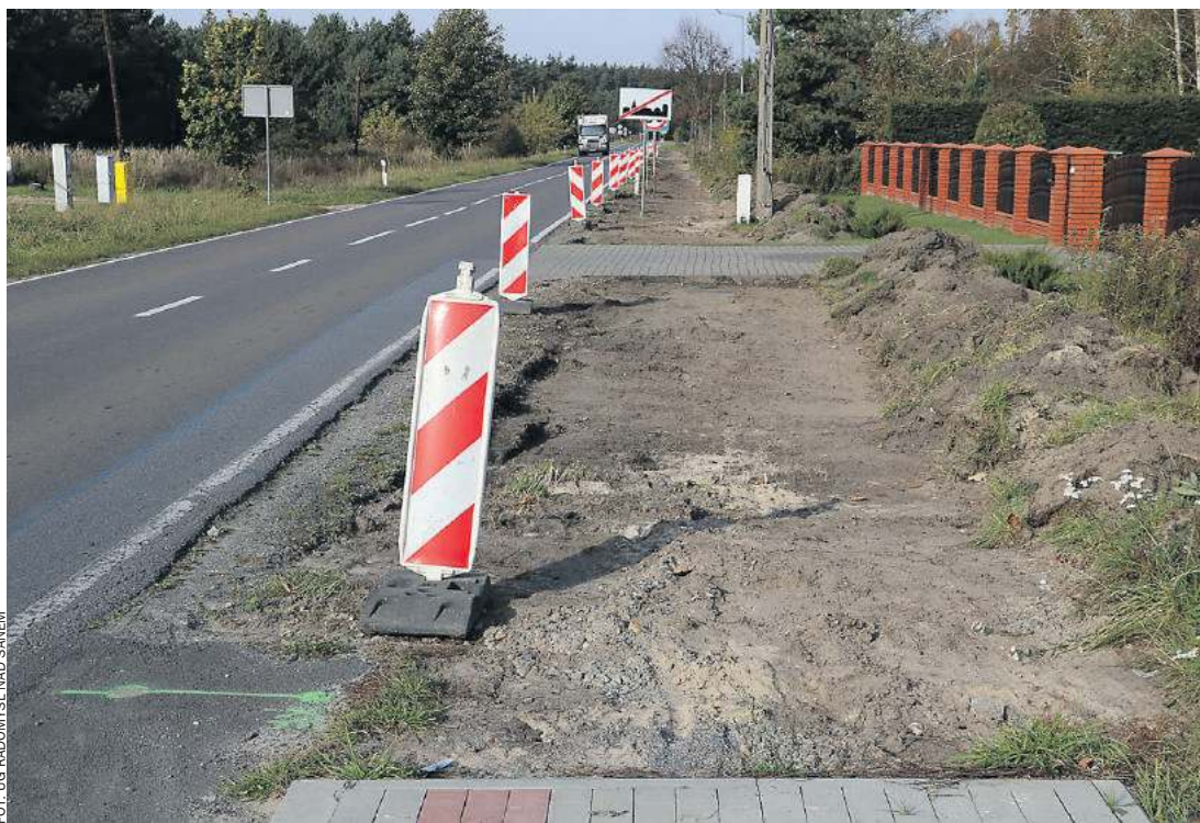
Budowa kolejnego odcinka chodnika poprawi poziom bezpieczeństwa pieszych
