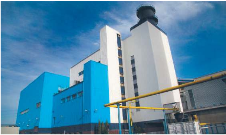
Elektrociepłownia na Wrotkowie unowocześnia się i zwiększa swoje moce energetyczne
