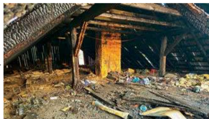
Podpis pod zdjęciem: Rodzina z Kuchar Królewskich w gm. Sochocin potrzebuje pomocy, by odbudować dom.
