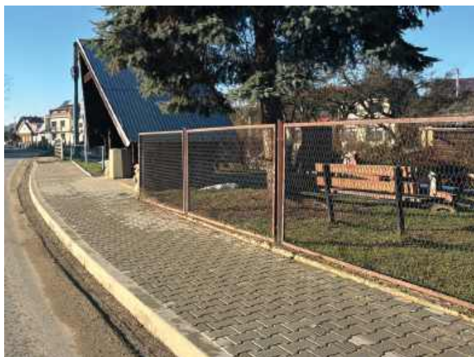
Nový chodník v centre obce
