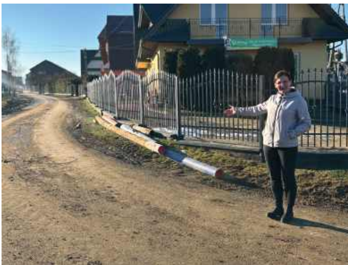
Richtárka ukazuje ako pokračujú práce v Krempachoch
