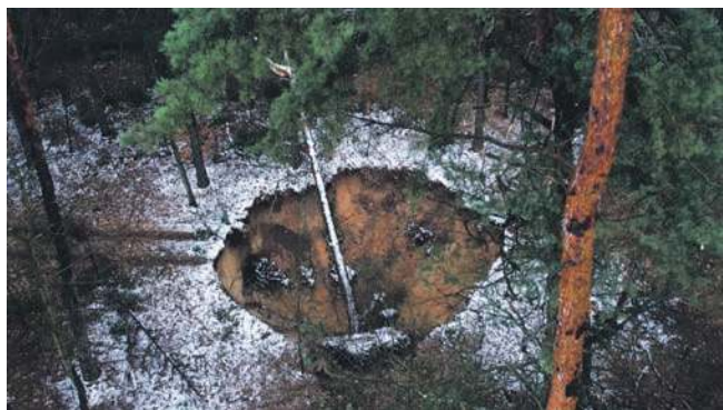
Zapadlisko przy ścieżce zdrowia w rejonie ul. Kopalnianej
