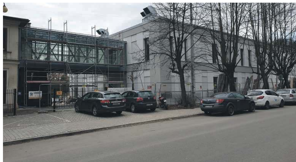
Salę gimnastyczną z budynkiem liceum łączy nowoczesna przewiązka
