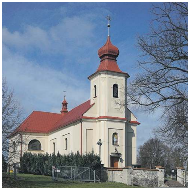
Odnowiona elewacja kościoła w Porębie Żegoty...
