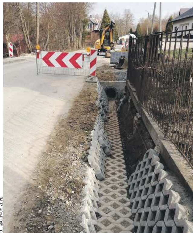
Trwa remont drogi powiatowej z Woli Filipowskiej do Ostrężnicy
