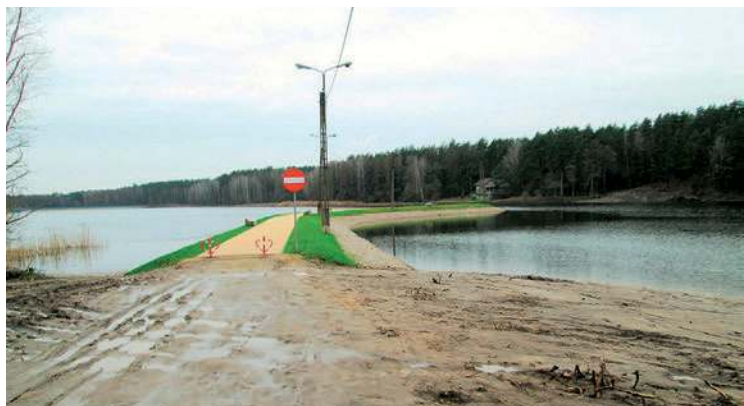
„Półwysep” na zalewie po remoncie
