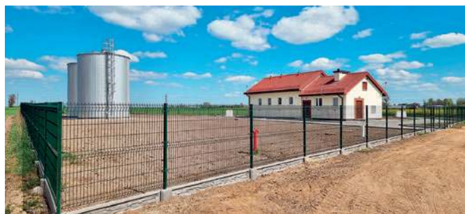
Stacja uzdatniania wody w miejscowości Pęczki-Kozłowo służy mieszkańcom gminy już od kilku miesięcy
