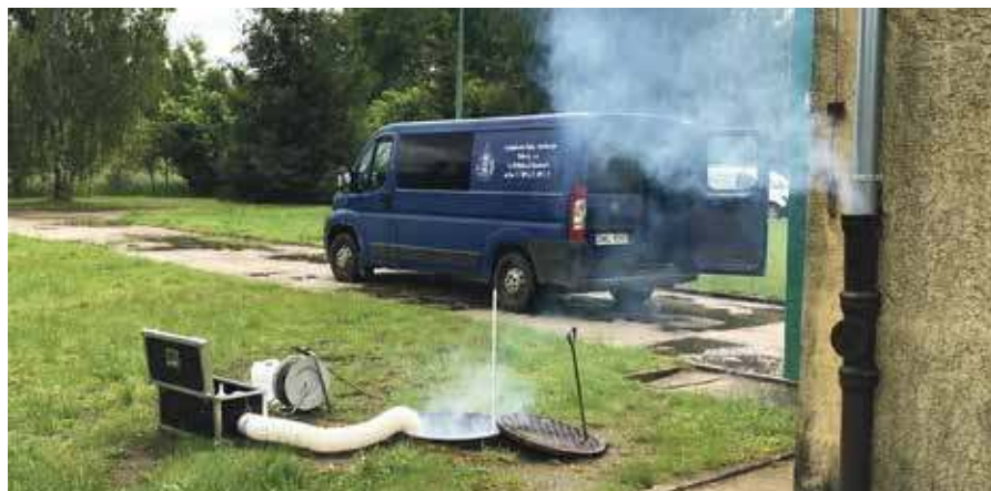
Sprawdzanie sieci kanalizacji sanitarnej będzie wykonywane za pomocą generatora nietoksycznego dymu – zimnej pary
