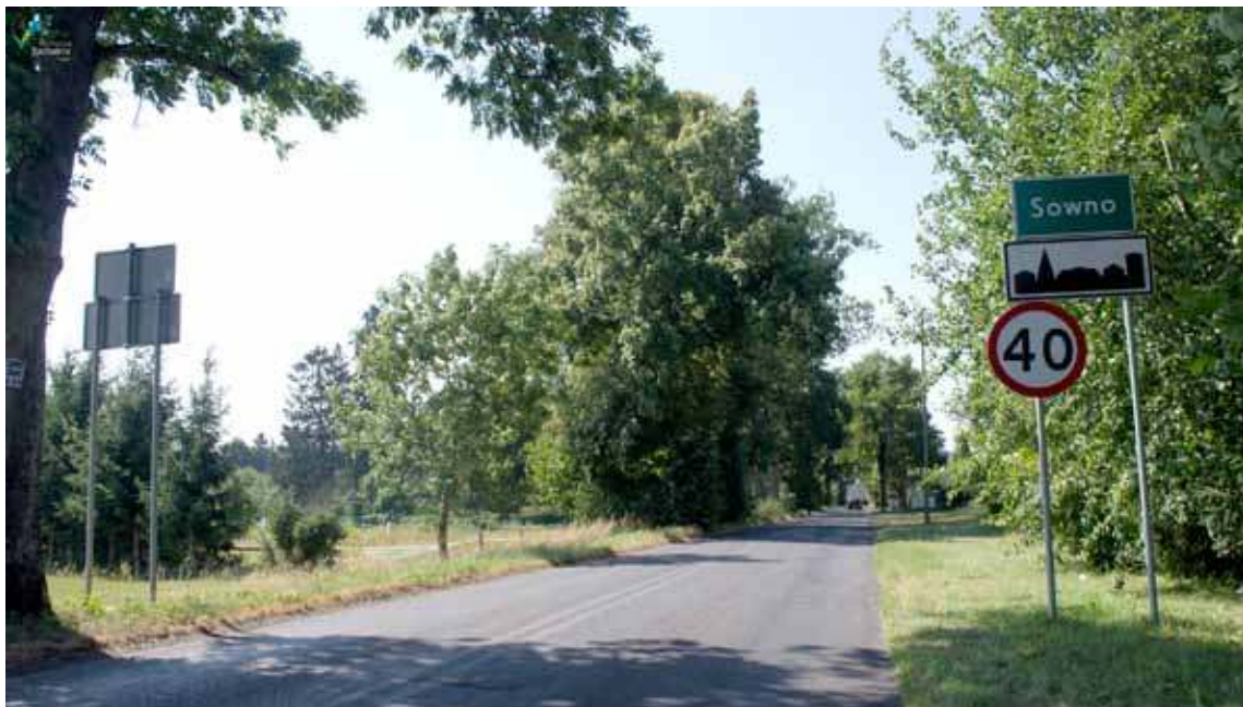
Gmina Stargard i powiat stargardzki wspólnie zrealizują inwestycję polegającą na budowie drogi Stargard-Sowno
