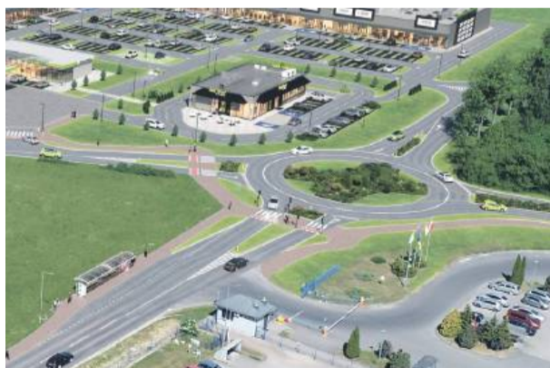
Tak może wyglądać zaprojektowane rondo, w którego budowę angażują się, oprócz inwestora, również gmina Strzelin i Samorząd Województwa Dolnośląskiego
