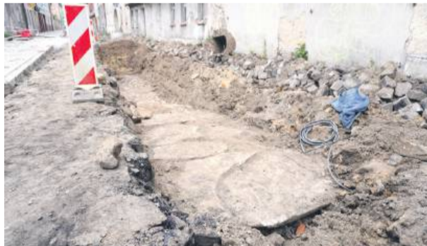
Podczas prac remontowych na ul. Strzeleńskiej natrafiono na granitowe płyty zniszczonej Bramy Nyskiej
