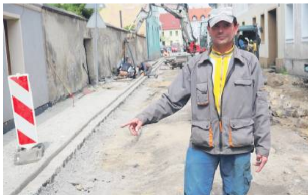
- Po remoncie ul. Strzelińskiej moja izolacja jest niżej niż chodnik. To oznacza, że woda nadal będzie przenikać i grzyb będzie się powiększał - uważa Waldemar Rataj
