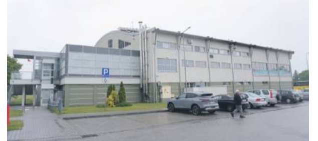
W aquaparku zostanie odnowiona sauna, schody ewakuacyjne oraz elementy uzdatniające wodę
