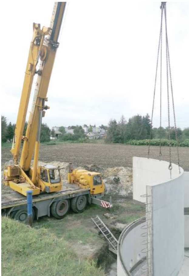
Trwa budowa nowego ujęcia wody w Wohyniu
