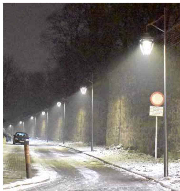
Na ulicy Warownej zamontowano 21 lamp ledowych
