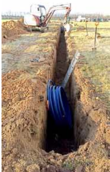
Powstanie również instalacja wodociągowa z dwoma punktami do czerpania wody
