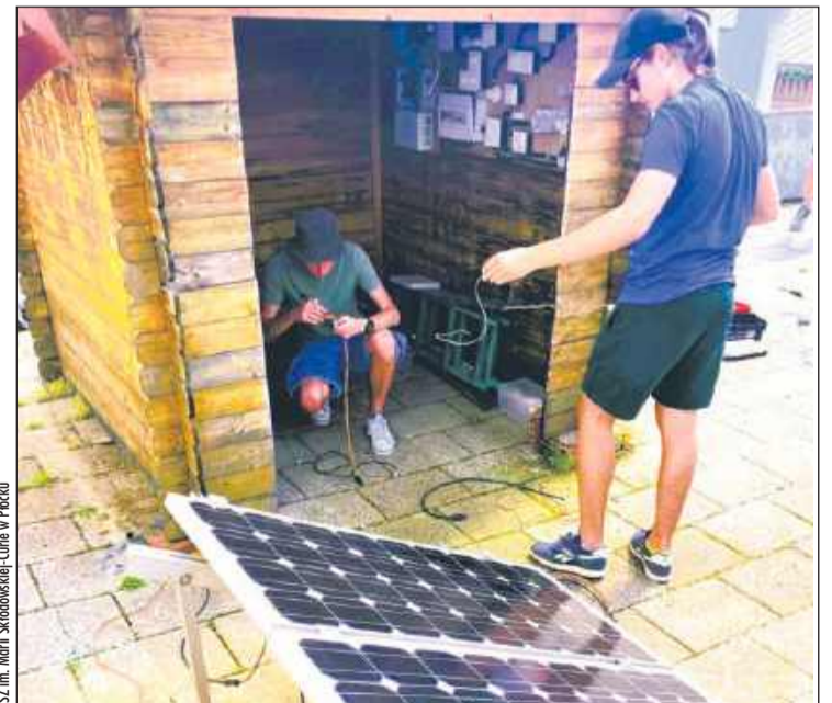
Elektrycy podczas budowy domu solarnego w Sewilli
