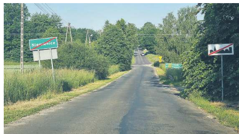
Powiat nie może znaleźć sposobu na nierzetelnego wykonawcę, przez którego droga w Niemienicach nie może doczekać się remontu
