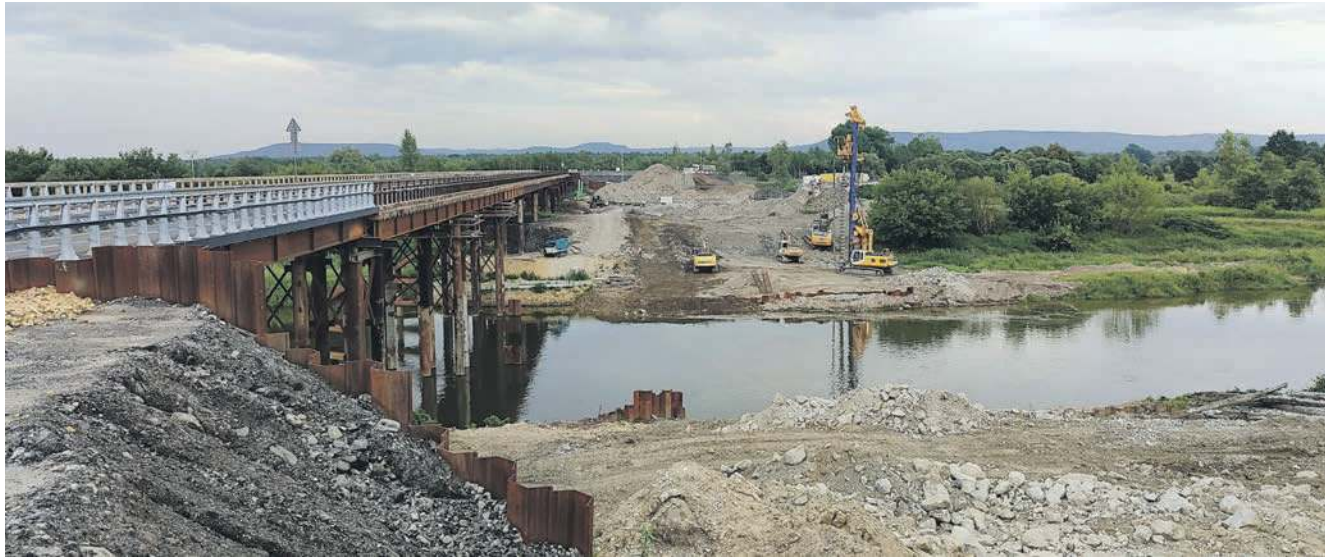
W miejscu rozebranego mostu w Jankowicach trwa budowa nowego. Obok przeprawa tymczasowa
