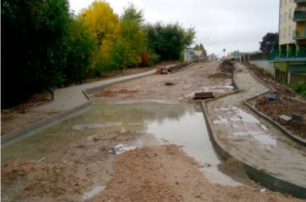
Choć na ulicy Milenijnej pozostało jeszcze sporo do zrobienia, miasto zapowiada, że inwestycja zostanie zakończona w terminie, czyli do 4 listopada
