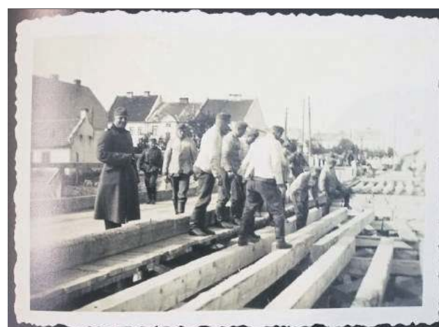
Budowa mostu na Orzycu. W głębi zabudowa makowskiego rynku.
