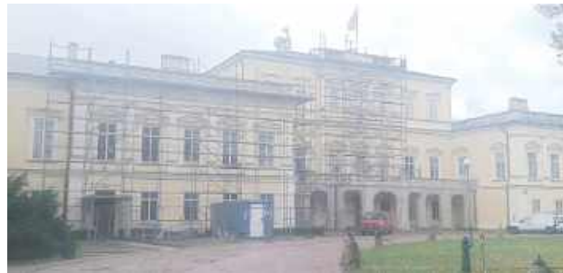
Zarówno mieszkańcy Puław, jak i odwiedzający miasto turyści już od pewnego czasu widzą rusztowania przy pałacu. Wszystko ma związek z prowadzonymi obecnie pracami remontowymi
