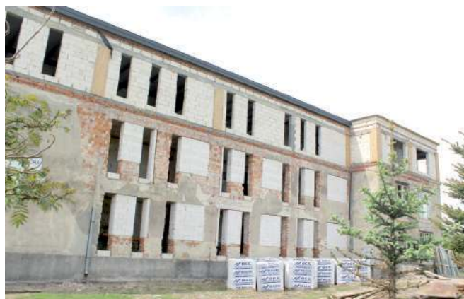
Dawna szkoła podstawowa w Trzciankach zmieni się w Dom Seniora. Prace na budowie trwają już od kilku miesięcy i zostaną ukończone dopiero w przyszłym roku. W budynku przewidziano miejsce dla 100 podopiecznych
