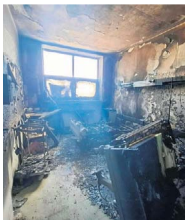
Zniszcznia po pożarze. Wybuchł on na 10. piętrze szpitala
