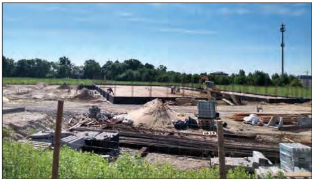
■ Od kilku tygodni trwają prace na działce należącej do Domexu. Ma tu powstać obiekt handlowy
