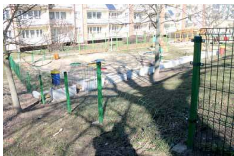
Tego typu zniszczeń jest niestety sporo na tym placu zabaw
