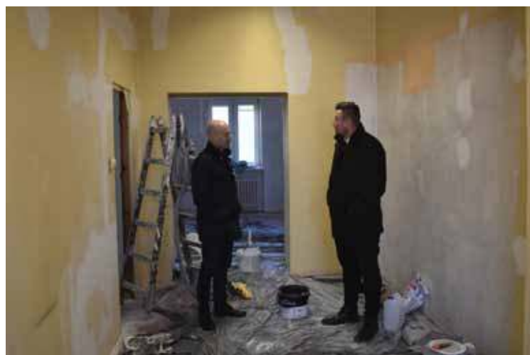
Obecnie trwa remont pomieszczeń
