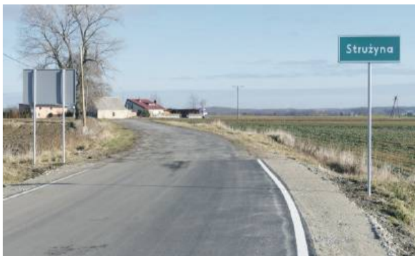
Brakujący fragment asfaltu przed Strużyną położono w ubiegłym tygodniu
