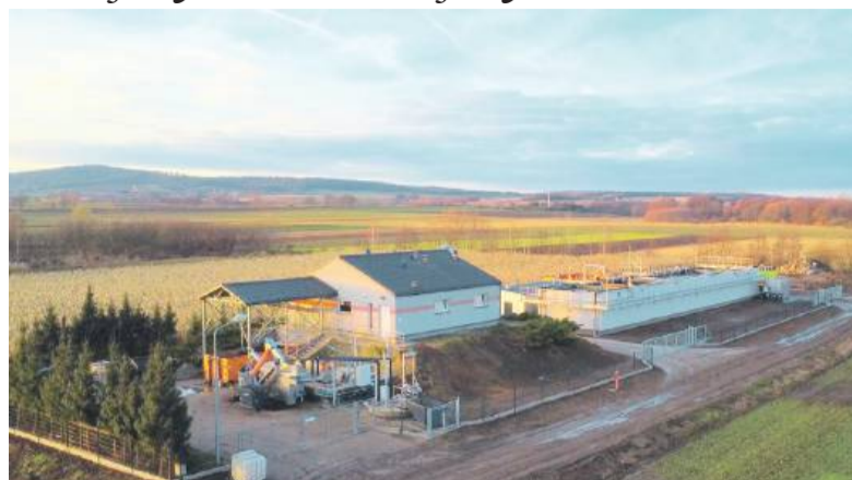
Kanalizacja oraz oczyszczalnię ścieków w Przewornie i Jegłowej
