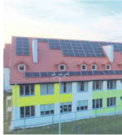
Termomodernizacja obiektów s
