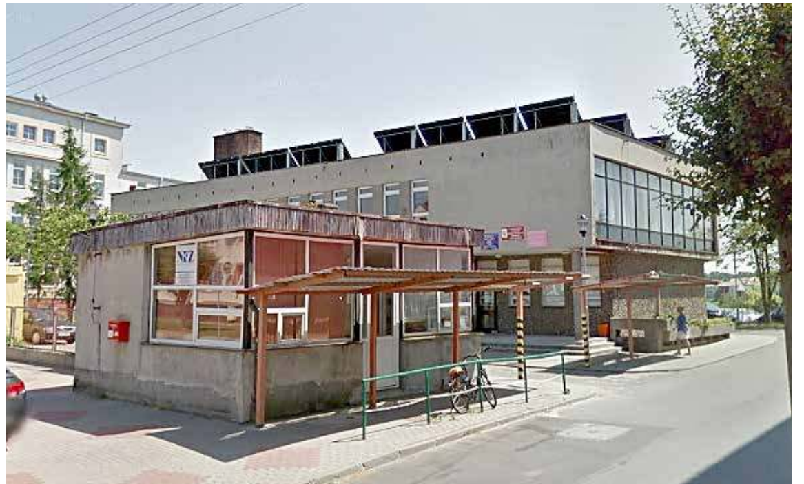
Piorun uderzył w budynek znajdujący się przy wejściu, co skutkowało uszkodzeniem centrali telefonicznej
