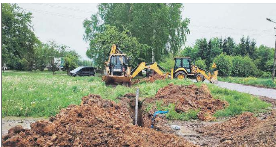
Jest to zadanie inwestycyjne pn. „Budowa wodociągu w miejscowościach Przegaliny Duże, Przegaliny Małe, Brzeziny, Żelizna i Kolembrody wraz z modernizacją ujęcia wody w Komarówce Podlaskiej”
