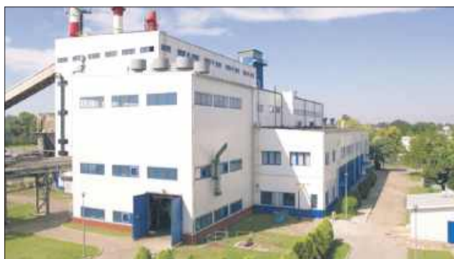
Do 20230 roku Elektrociepłownia Mielec musi zaprzestać spalania węgla.
