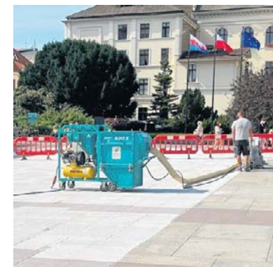
Roboty na miejscu ruszyły w poniedziałek, 7 września
