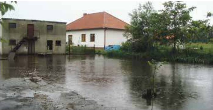
Tak wyglądał teren przy ul. Wiejskiej bez odwodnienia drogi wojewódzkiej
