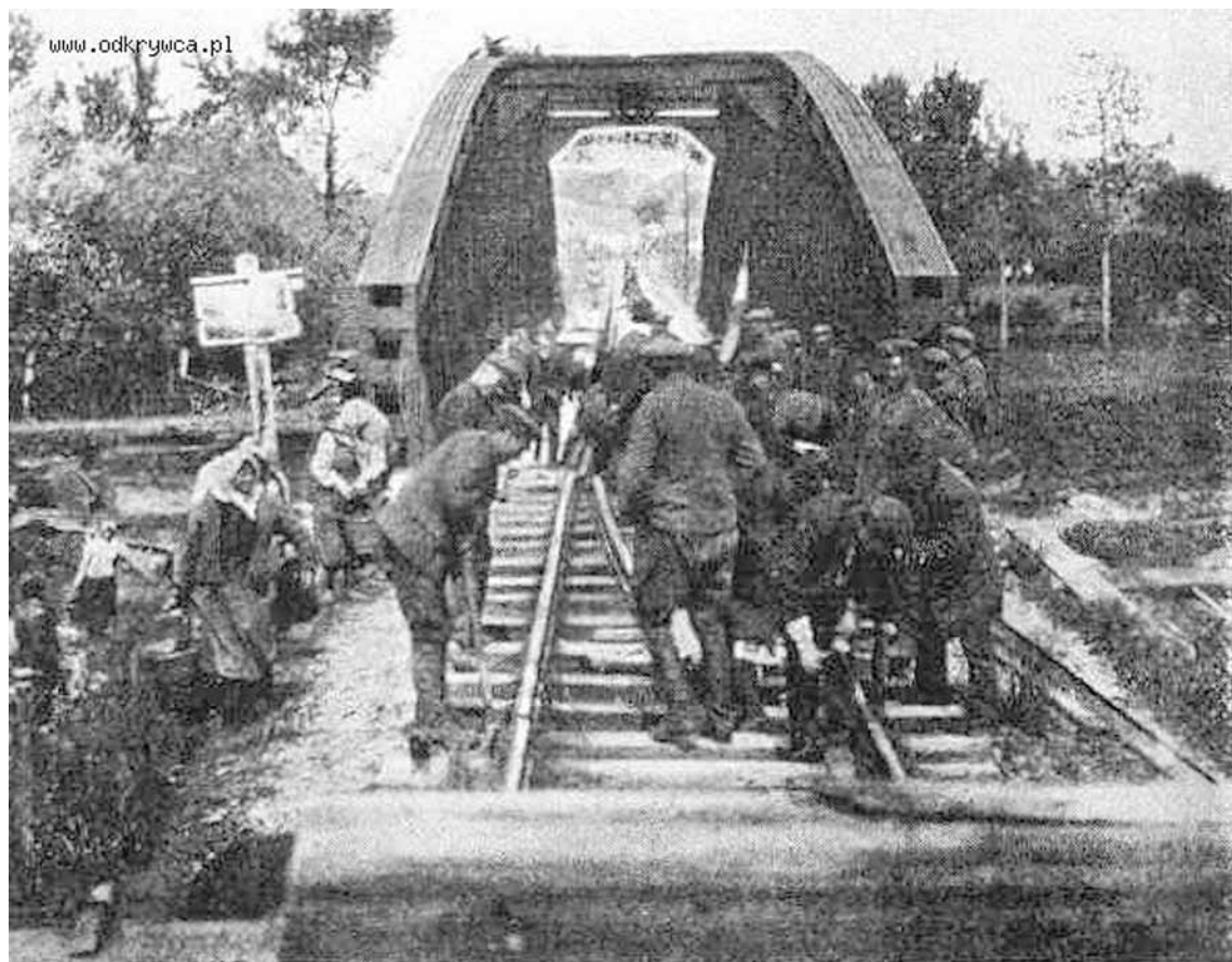
budowa mostu kolejowego na rzece * przez załogę pociągu pancernego * * *
