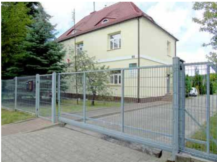
Na zdjęciu – nowogardzka „elektrownia”, kiedyś można było tutaj załatwić sprawy, ale to już przeszłość, dzisiaj trzeba jechać do Goleniowa
