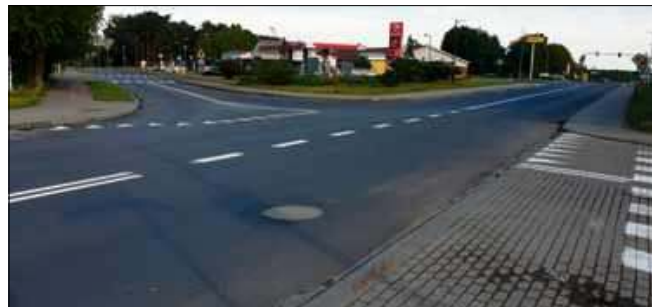
Plany budowy ronda zostały przystopowane z uwagi na problemy, jakie wynikły z wytyczeniem dwóch zjazdów ze stacji benzynowej.
