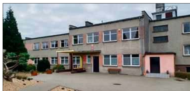
Zespół Szkolno-Przedszkolny w Kórnicy zostanie wyposażony m.in. w pompę ciepłą.
