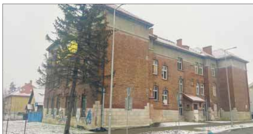
Dawny budynek SP6 w Jaworznie
