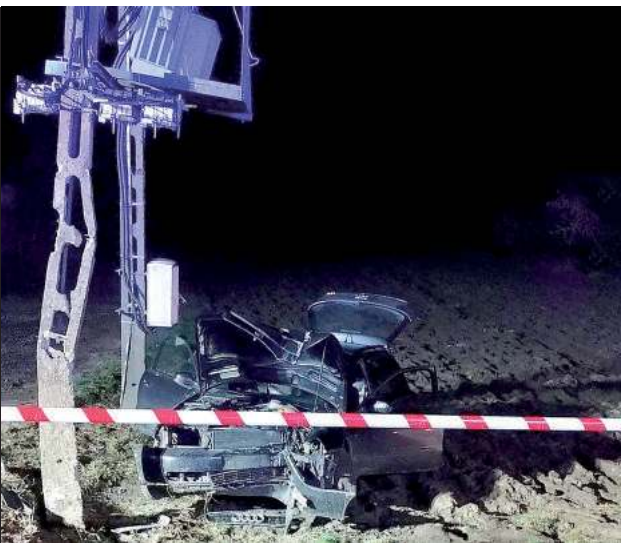
Auto zostało poważnie uszkodzone, słup energetyczny też
