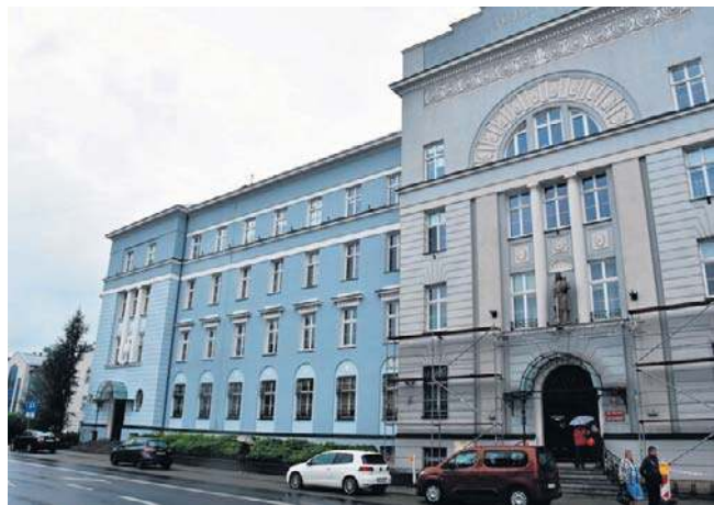
Renowacji poddano już część południową budynku. Robotnicy pracują teraz przy elewacji od strony północnej
