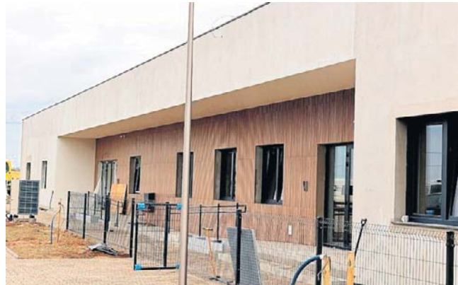
Prace są na finalnym etapie, a obiekt nabiera ostatecznego kształtu
