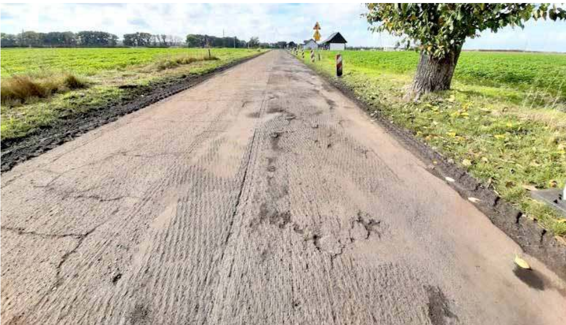
Trwają prace związane z modernizacją nawierzchni jezdni oraz chodników drogi prowadzącej do miejscowości Strzebielewo
