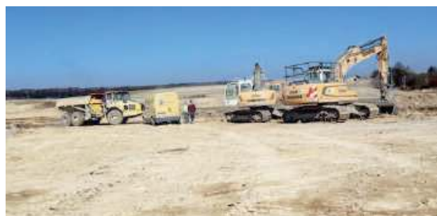
Obecnie prowadzone są roboty rozbiórkowe i ziemne
