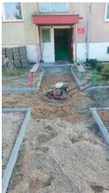
Przebudowa chodników w msc. Kalinka
