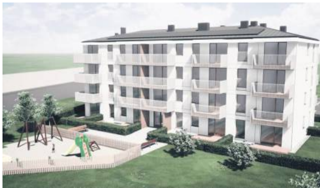
Investycja realizowana w Hrubieszowie obejmuje budowę czterokondygnacyjnego budynku.
