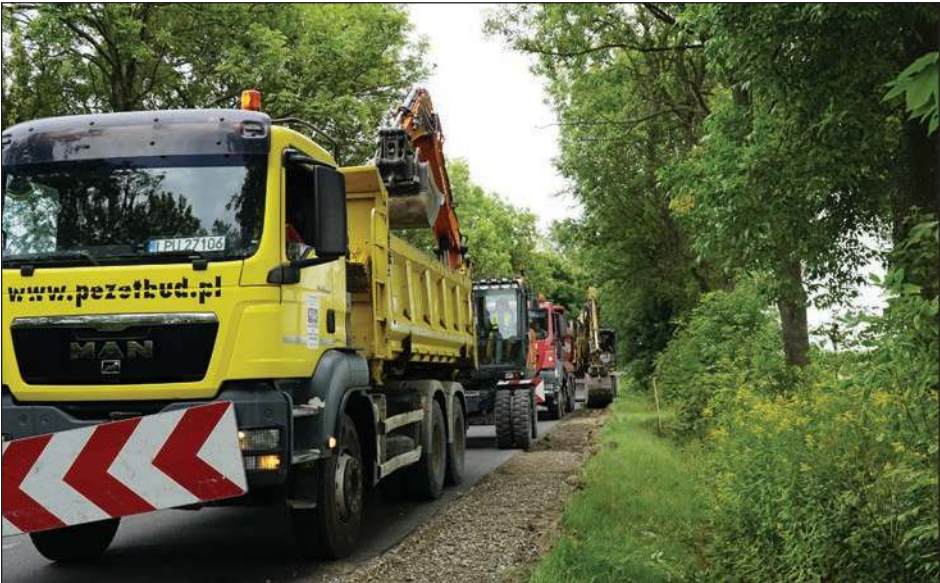
3,5-kilometrowy odcinek drogi z Ryk w kierunku Rososzy zyska pobocza z kruszywa łamanego. Docelowo na jezdni pojawią się linie wzdłuż krawędzi jezdni
