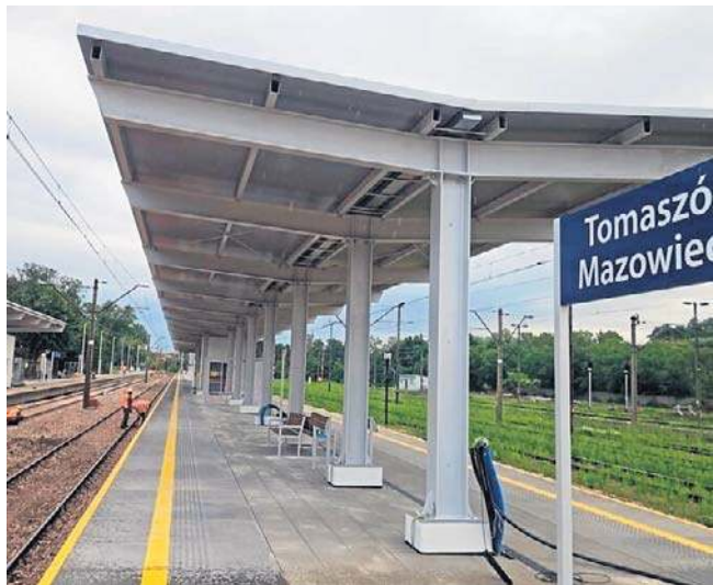
Na stacji Tomaszów Mazowiecki są już zadaszone perony
