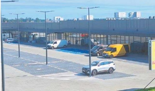
Obecnie trwają prace wykończeniowe w obiekcie
