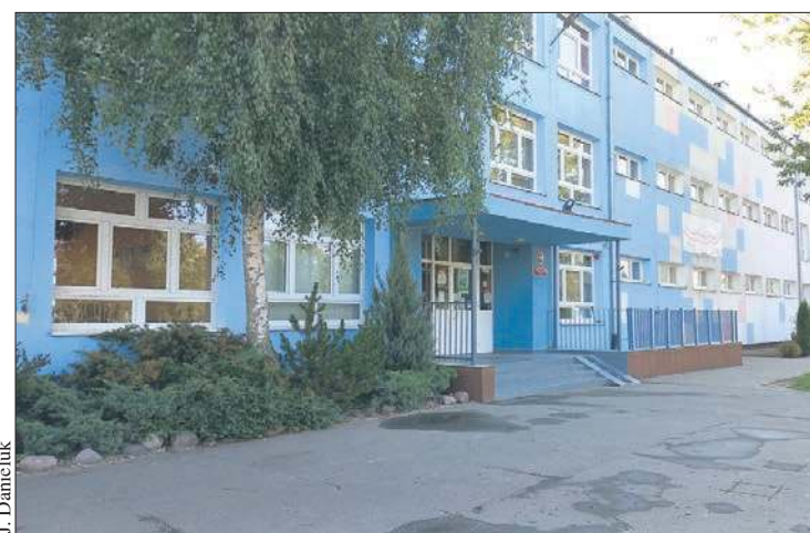
W budynku Szkoły Podstawowej nr 3 przy ul. Kossobudzkiego ma powstać żłobek
