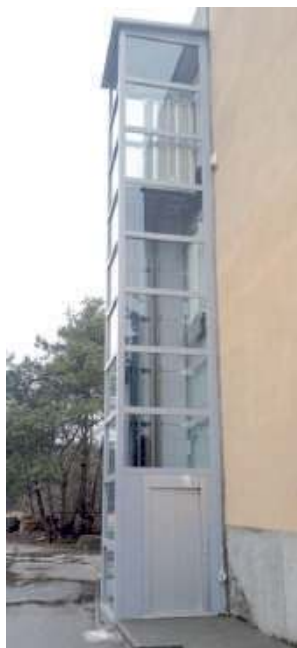
Winda usytuowana jest tuż przy wejściu na plac Urzędu Gminy
