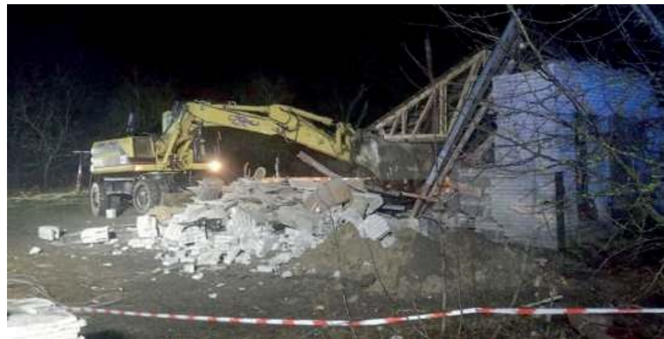
Po wydostaniu ciała mężczyzny konieczna była natychmiastowa rozbiórka budynku, który w każdej chwili mógł się zawalić
