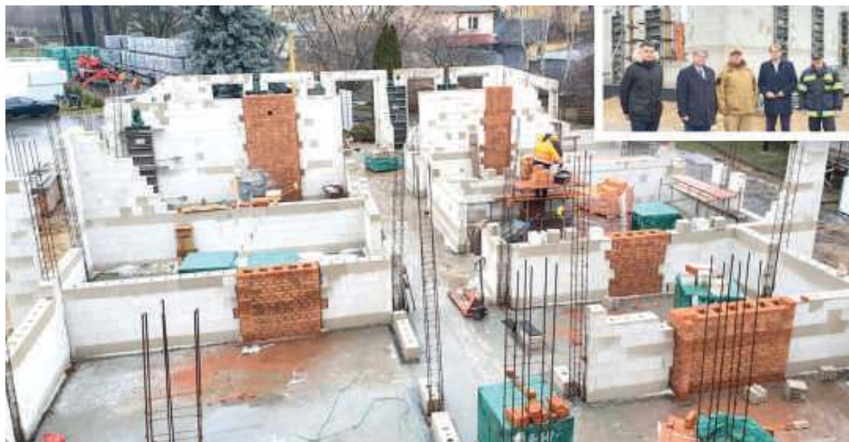
- Budowa realizowana jest zgodnie z planem i nie stwierdzono żadnych opóźnień. Prace rozpoczęto w 2021 r., a jego zakończenie planowane jest na rok 2023 - informował Tomasz Majewski, komendant PSP w Łukowie, podczas rady budowy 27 stycznia (fot.KP PSP w Łukowie)
