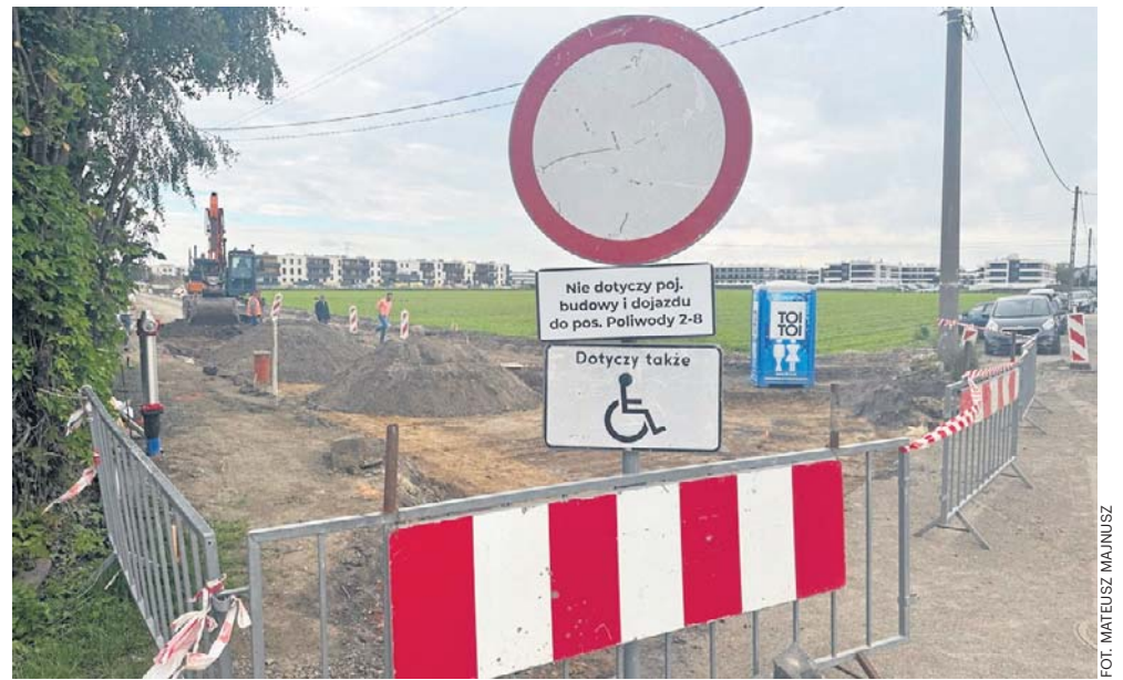
Powstaną chodniki oraz droga dla pieszych i rowerów. Zaplanowano również pasy postojowe, choć tylko na wybranych odcinkach ulicy.
