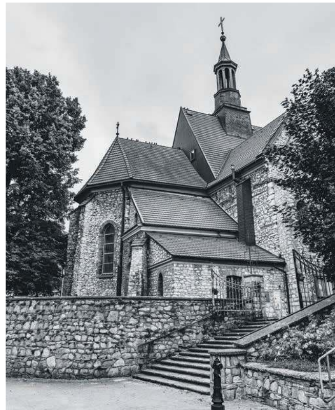
Schody przy jednej z bram, kamienny mur otaczający świątynię oraz widok na jej starszą część
