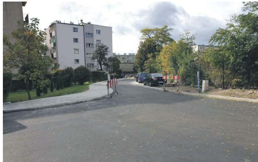
Asfalt już leży, większość robót wykonano
